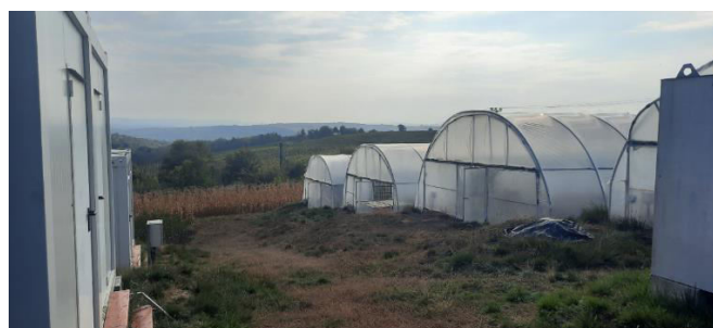
COMPLEXUL DE SOLARII
